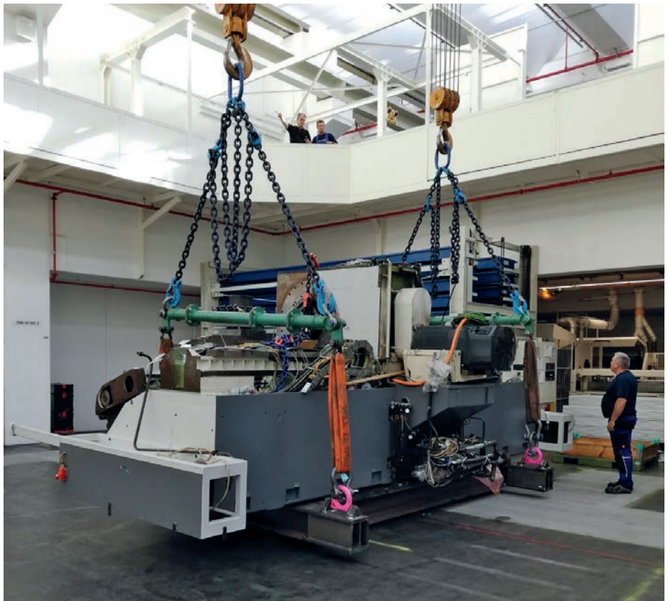
NIG-Monteure bei der Millimeterarbeit an den Schwerlasthaken
