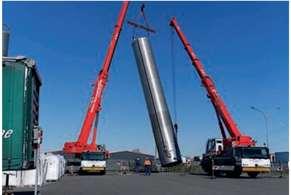
Verlagerung eines Rohstoffsilos von REHAU Bourges in Frankreich zu REHAU in Triptis /Thüringen
